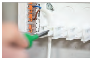
Positionner les câbles dans les décharges de traction
